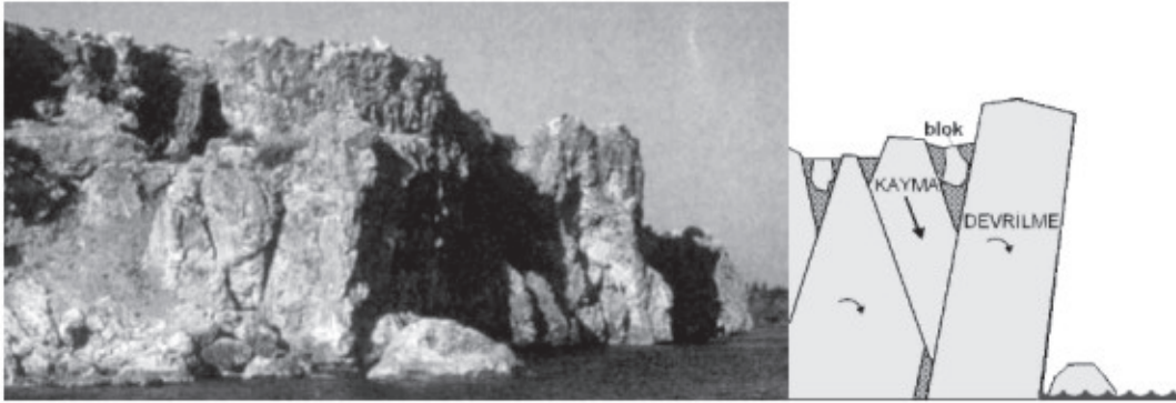
Şekil 10. Konyaaltı varyantında çoklu ikincil devrilme mekanizması (Dipova, 2003).
